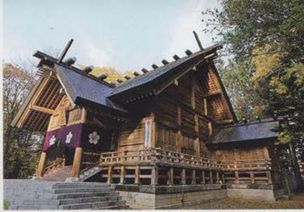
▶修復・甦った社殿
