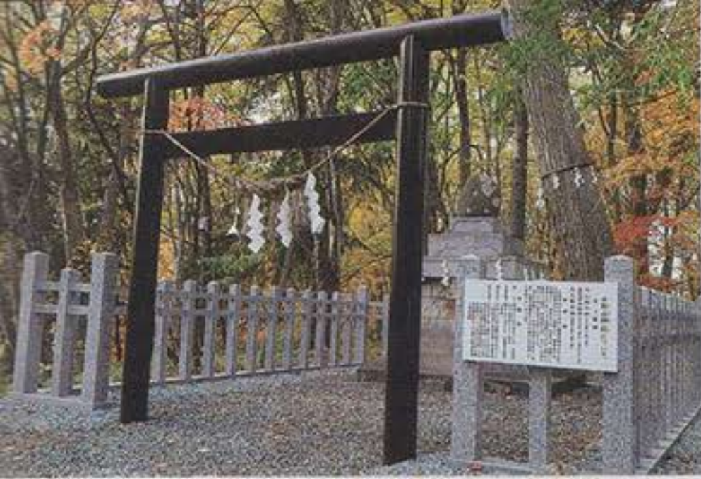
◀花崗岩で玉垣建立 (木製玉垣腐蝕による)
